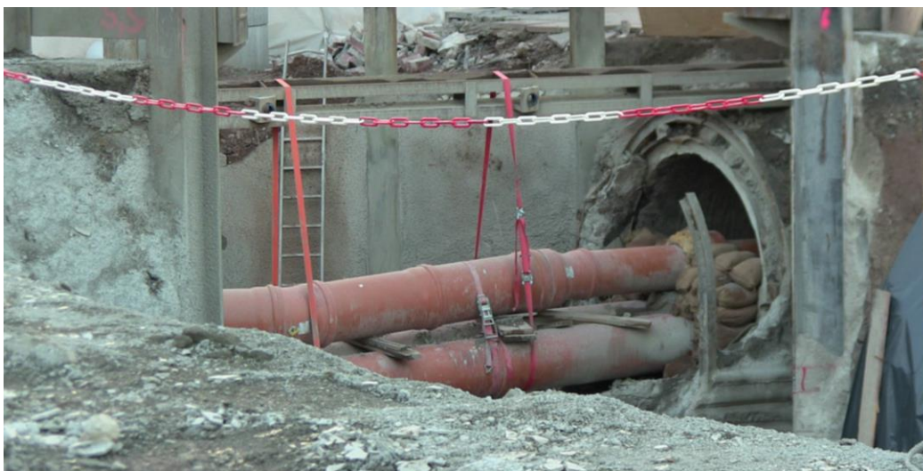
Abb. 2.7.1 Bauzeitliche Umleitung Abwasserkanal Cannstatter Straße / Sept. 2017
