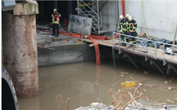
Abb. 1.2: Vollaelaufene S21-Bauarube am 03.10.2017
