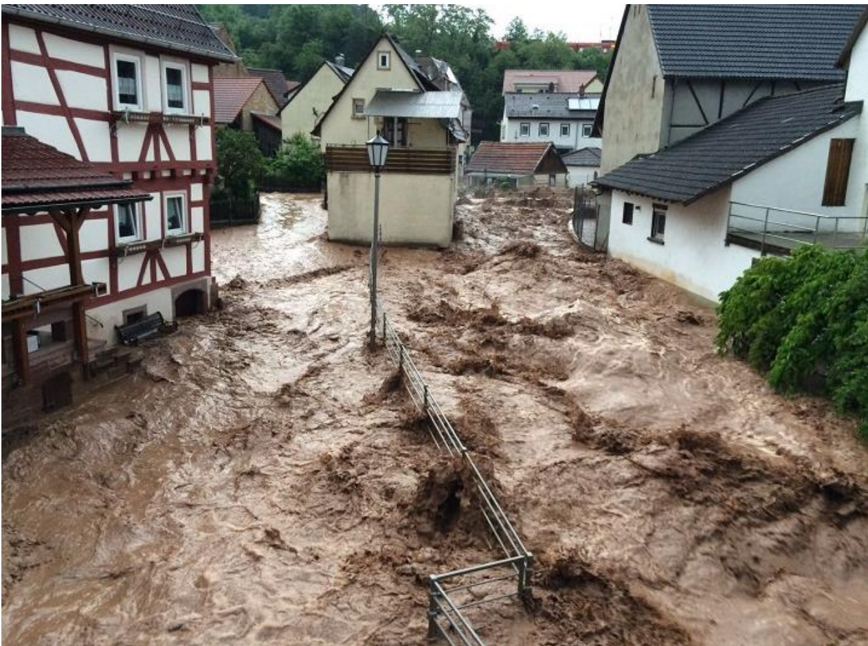
Abb. 3.3.5: Überflutung Braunsbach /Ba-Wü durch Unwetter am 29./30. Mai 2016
