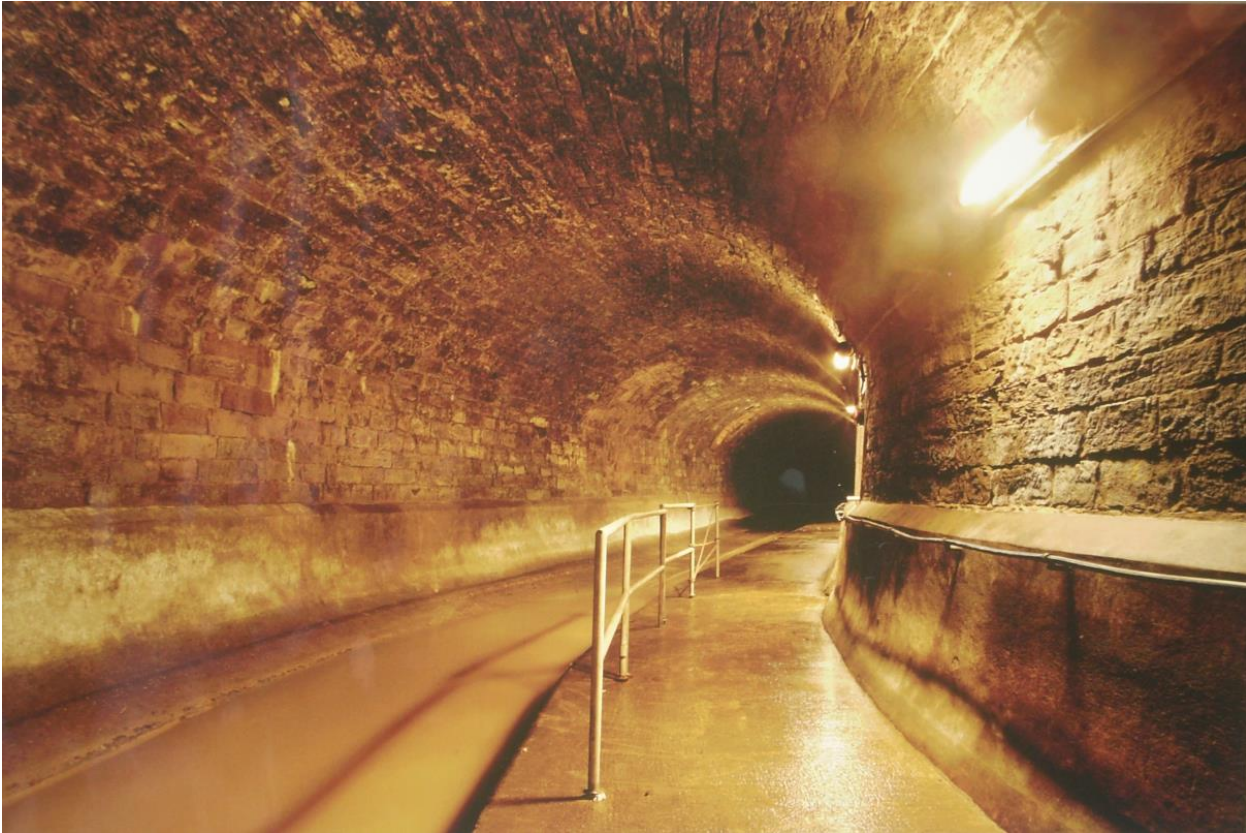
Abb. 2.3.1: Blick in den Nesenbach-Kanal (beim Neckartor) / Stuttgart, mit Trockenwetter-Abflussrinne
