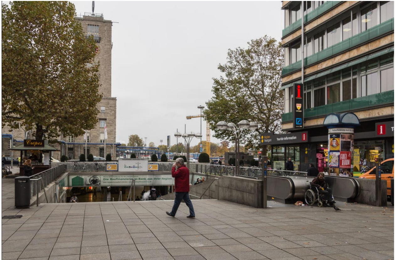
Abb. 3.3.1: Zugang zur Klett-Passage in der Königstraße – ohne jeglichen Überflutungsschutz!
