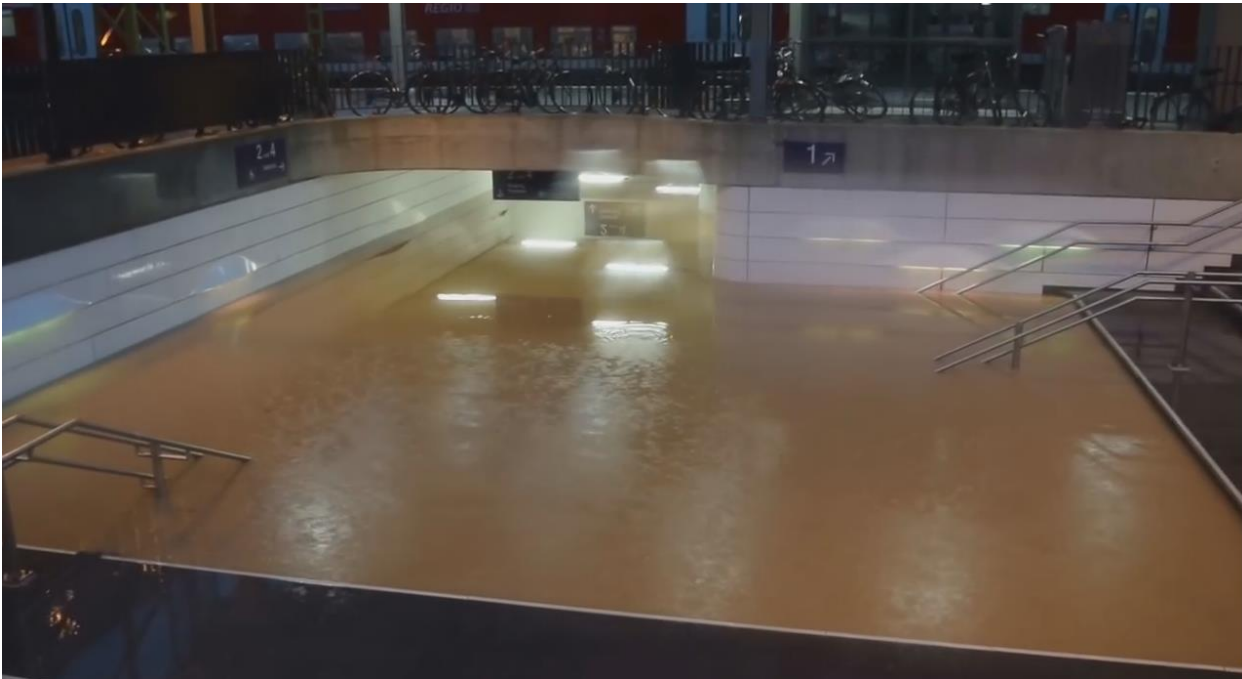
Abb. 3.3.4: Überflutete Bahn-Unterführung Schwäbisch-Gmünd nach Unwetter am 29.Mai 2016
