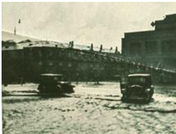
Abb. 1.2.1: 07.05.1931, Überflutung des Bahnhofsvorplatzes. Das Wasser stand bis zur Treppe in der Empfangshalle des Hauptbahnhofs.
