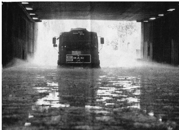
Abb. 1.1.5: 05.06.2000, ein Hagelgewitter flutet die Klett-Passage von der Königstraße bis in die S-Bahn (links). Geflutete Unterführung unter dem Charlottenplatz (rechts). Bildquellen siehe Anhang 1.2
