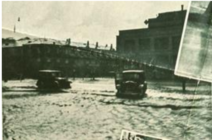
Abb. 2.2: 07.05.1931, Überflutung des Bahnhofsvorplatzes. Das Wasser stand bis zur Treppe in der Empfangshalle des Hauptbahnhofs.
